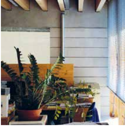
Innenraum mit sichtbaren Kalksandsteinwänden und Brettschichtholz-Träger an der Decke
