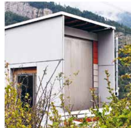
Lüftungsklappe auf dem Dach (2 m × 1.8 m)
